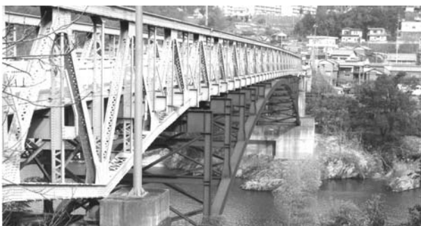
図1 改築された三好橋
