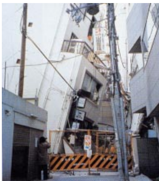
図1 地震によって倒れかけたビル (1997.1.30 神戸市内)
